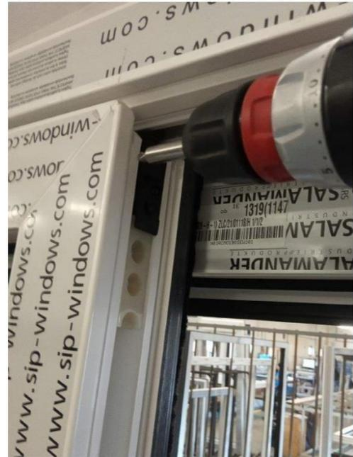
Fig. ... Smontaggio del marginatore dell'anta. Fig. ... Svitatura del bullone di fissaggio del gancio.
